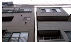
足場を使わず、隣家との間隔がわずかでも建築が可能(NS構法)。
