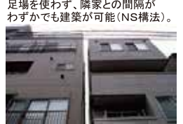
足場を使わず、隣家との間隔がわずかでも建築が可能 (NS構法)。
