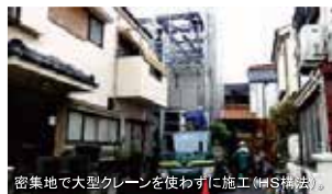
密集地で大型クレーンを使わずに施工(NS構法)。
