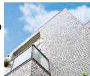
太陽の光で汚れを浮かせ、雨が降ると洗い落ちる光触媒タイル。
