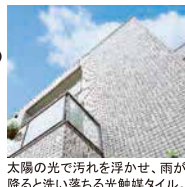
太陽の光で汚れを浮かせ、雨が降ると洗い落ちる光触媒タイル。
