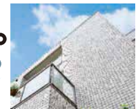
太陽の光で汚れを浮かせ、雨が降ると洗い落ちる光触媒タイル。
