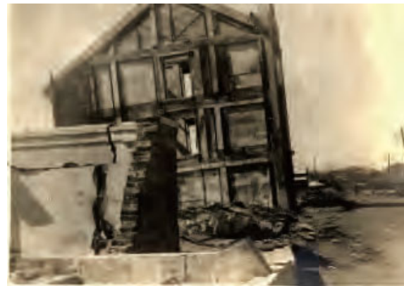
傾斜した建物
